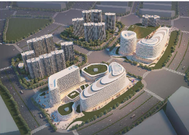
建业集团南阳凯旋工程二期
